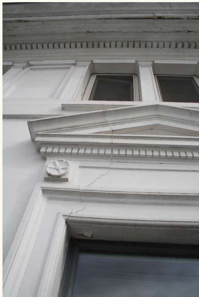
scheur vraagt extra onderzoek
