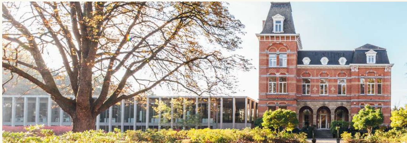
Uitbreiding kantoor: kasteel Ter Poorten Hasselt
