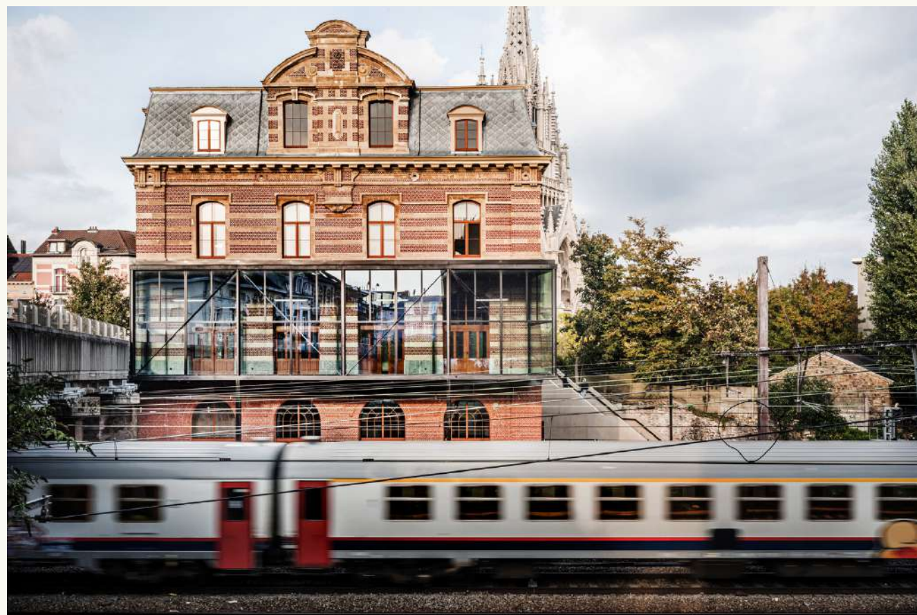
station Laken (B-architecten)
