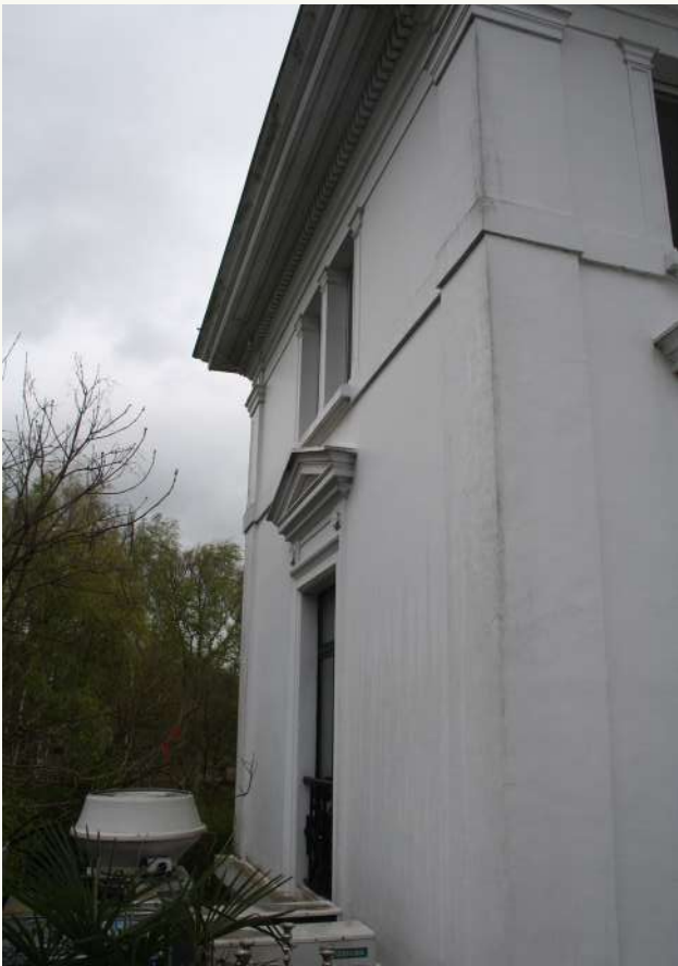
westgevel vanaf plat dak +1
